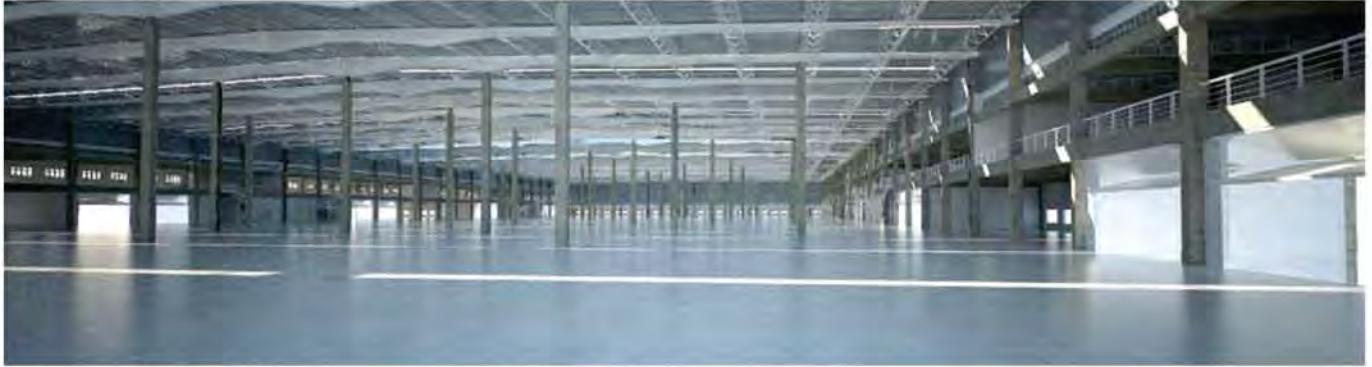
Vista interna dos galpões
